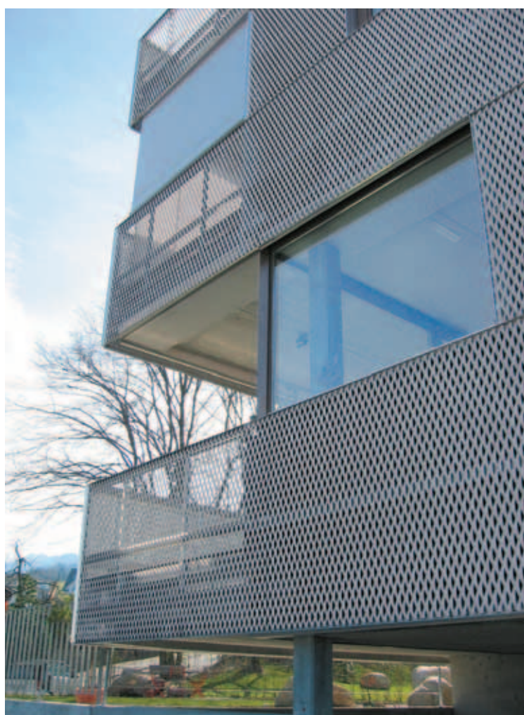
Projekt: Halter Generalunternehmung AG (CH) - Masche: Ambasciata - DL 110 x DC 40 (52) - av 24 x sp 2 mm Kugelgestrahltes Aluminium - Foto: Metallpfister
